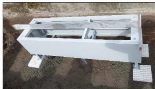
Erdsockel waagrecht aufstellen, auf Einbauhöhe achten! Arbeiten mit Wasserwaagen kontrollieren!
