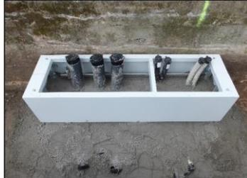
Bild 16: Erdssockel bis Unterkante Sockelblende verfüllt
